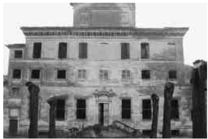
Villa Obizza, a settembre il via ai lavori per la messa in sicurezza
